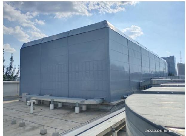
空气源热泵机组隔声罩
