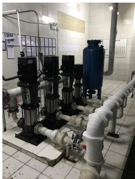
基础减振、弹性材料包扎
