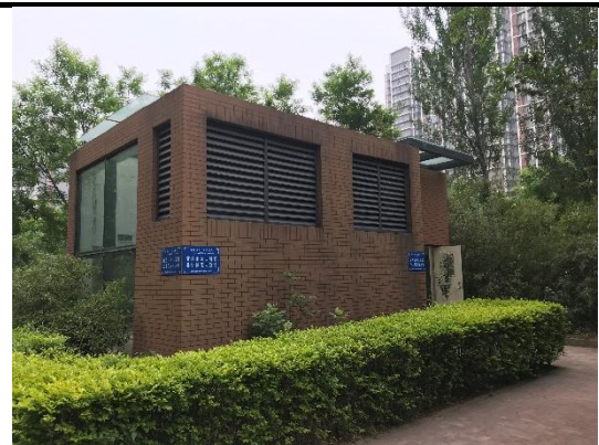
地下车库排风井
