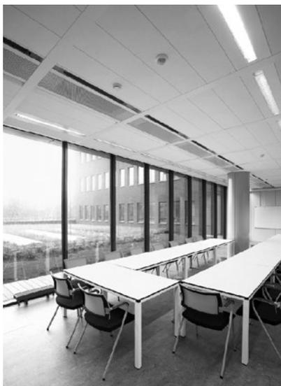
图4 主动式冷梁与金属辐射板结合布置效果
