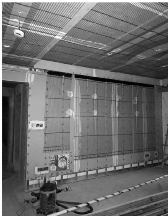
图2 毛细管辐射板布置效果
