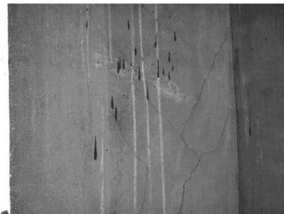
图3 采用毛细管辐射板的墙面龟裂
