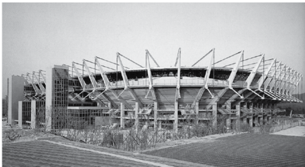
蔚山文殊足球竞技场引杖钢丝绳屋顶结构及透视(构建加工美的表露)
