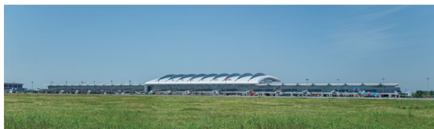
航站楼空侧全景照片
