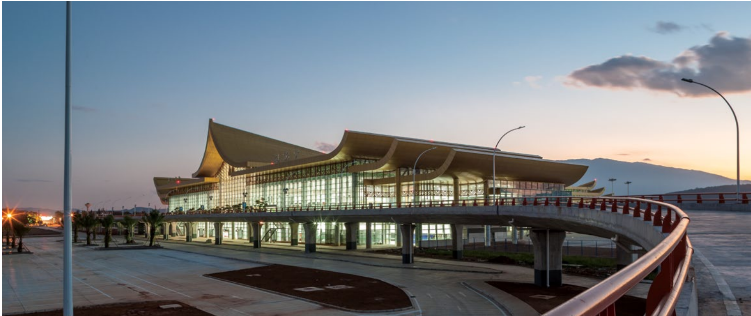
航站楼侧面照片
