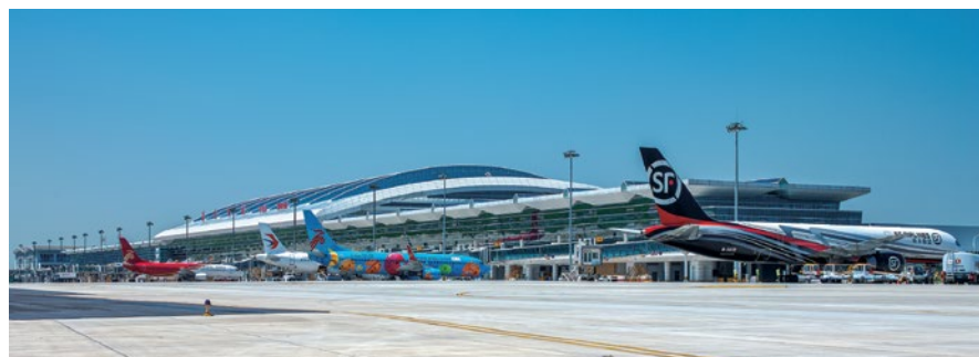
航站楼空侧近景照片
