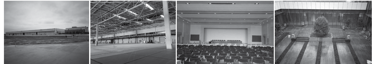
机库及综合展览馆实景
